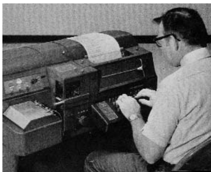
Fernschreiber mit Lochstreifenstanzer und -sender
