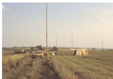
Holzmastenanlage für die Dipole
