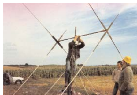
Die Quad wird zusammengebaut
